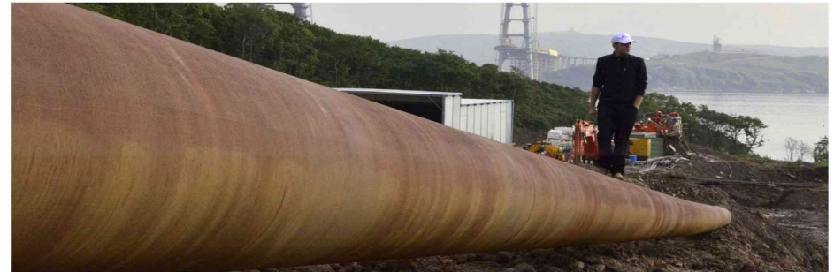
Un hombre camina sobre un gasoducto en construcción. (Reuters)
